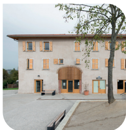
© V. Rigassi - Logements sociaux et commerces - Montseveroux (38)
