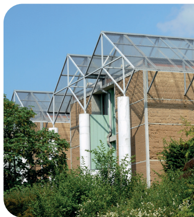
© CRAterre, T. Joffroy - Mur en terre
