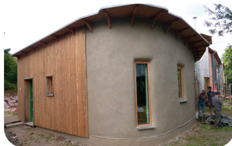
© Construction paille - Etienne Maire
