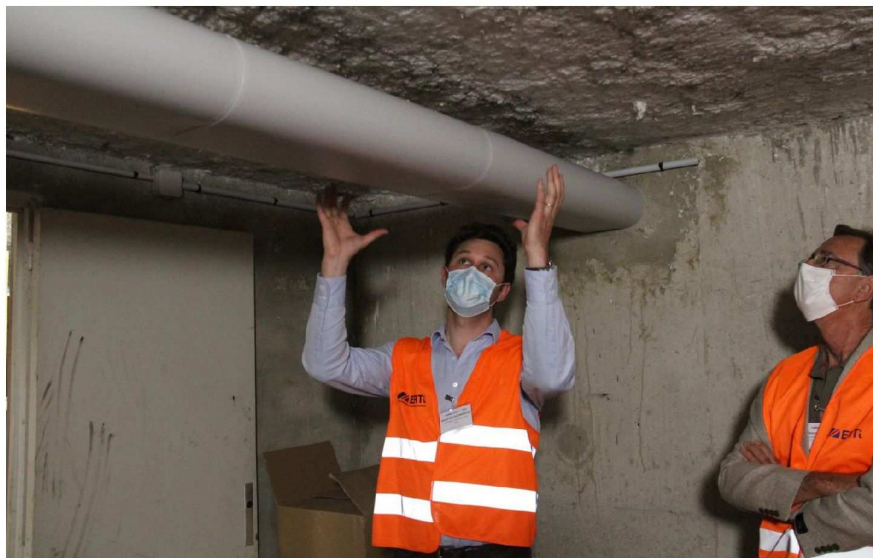
Un tuyau d'eau chaude situé au sous-sol d'un immeuble des Sé nardes recouvert de laine de roche et d'un habillage en PVC.
