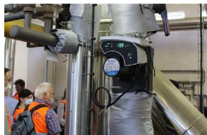
Une housse isolante fermée avec des scratchs sur un point singulier.
