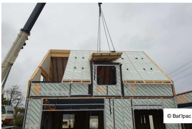
La maison est isolée avec les blocs Ipac de la société Bat'Ipac, des plaques de carton alvéolaires recouvertes d'une membrane d'étanchéité.
