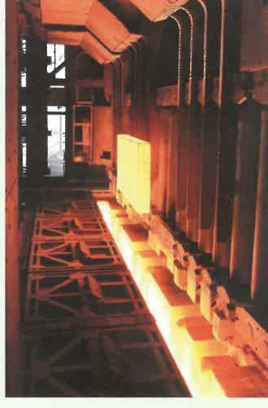
Vue du four (source Dillinger France)
