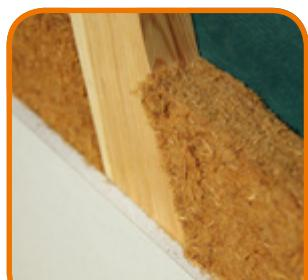
La laine de bois et les panneaux en fibre de bois sont fabriqués grâce au défibrage du bois.
