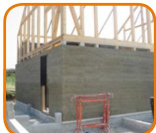
Le béton, l'enduit et le mortier de chanvre sont obtenus par le mélange de la chènevotte et d'un liant, le plus souvent à base de chaux. Le béton de chanvre peut être projeté avec une machine spécifique ou coulé entre banches. Le couple chaux-chanvre utilisé pour la fabrication du béton de chanvre doit être validé par un laboratoire (liste disponible sur [www.construire-en-chanvre.fr](http://www.construire-en-chanvre.fr)).
