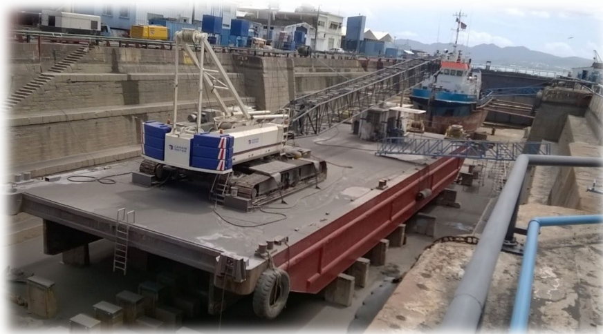
Figure 13 - Barge au bassin - SOURCE : Caraïb Moter
