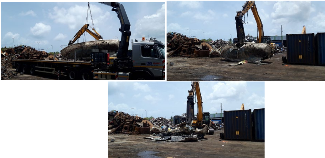
Figure 38 - Déconstruction à la pince cisaille - SOURCE : Caraïbes Environnement Développement
