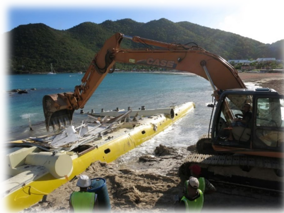
Figure 15 – Pelle mécanique – SOURCE : Clean Océane
