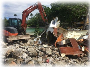
Figure 43 – Déconstruction - SOURCE : Sté. Service Plongée
