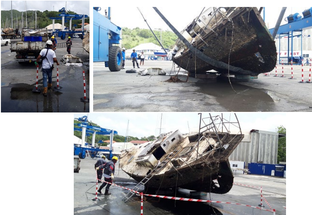
Figure 33 – Dépose au sol - SOURCE : Caraïbes Environnement Développement
