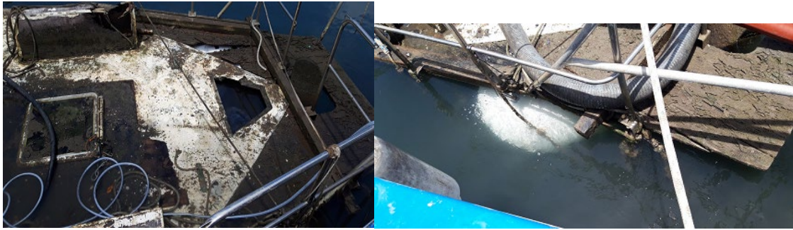
Figure 22 - Mise en place des ballons - SOURCE : Caraïbes Environnement Développement
