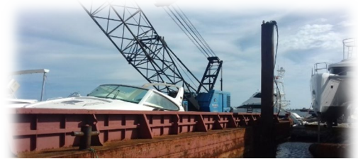
Figure 34 - Bateau sur barge - SOURCE : SNR
