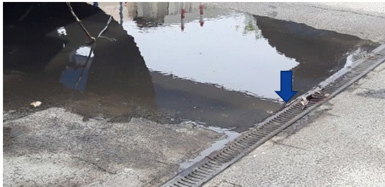
Figure 35 – Dispositif de récupération des eaux usées - SOURCE : Caraïbes Environnement Développement
