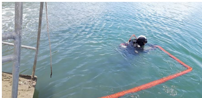
Figure 20 – Mise en place d'un barrage anti-pollution - SOURCE : Caraïbes Environnement Développement
