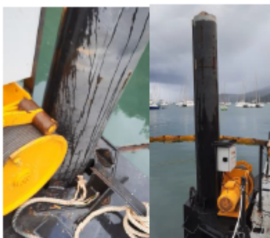
Figure 11: Pieux de soutien
